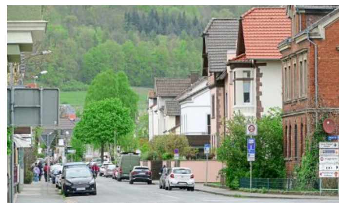
Der urbane Raum am Stadteingang Albaxerstraße ist das größte Einzelprojekt im Stadtentwicklungskonzept. Foto: Sabine Robrecht
