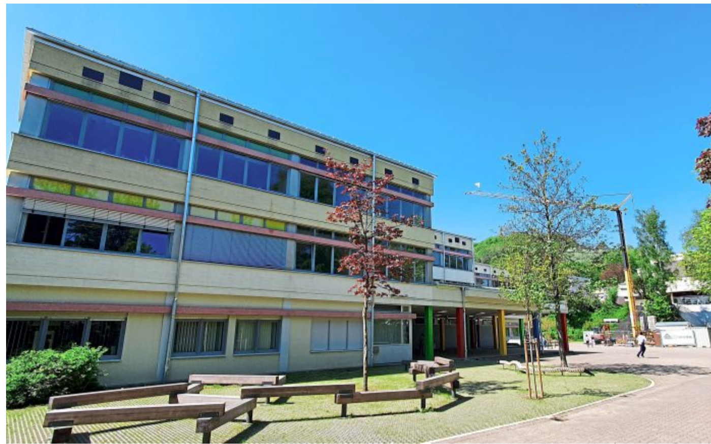
Die Sekundarschule Höxter: Der Baukran für das neue Heizzentrum ist ein schönes Symbol für die Baustelle Schulzentrum.
