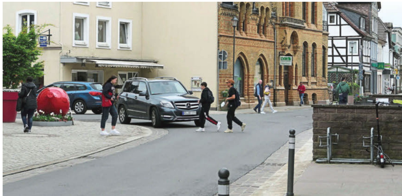
Der Einmündungsbereich Grubestraße/Nicolaistraße/Corbiestraße in Höxter ist immer stark von Fußgängern frequentiert. Die drei Zebrastreifen werden wohl vor Jahresende nicht kommen, kündigte die Verwaltung im Ortschaftsausschuss an. Poller wie hier in der Grubestraße sollen in der Nicolaistraße das Parken auf Gehwegbereichen unterbinden. Foto: Sabine Robrecht
