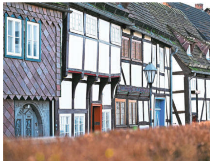
Die Weserstadt ist nicht nur geprägt von großen Fachwerkhäusern, sondern auch von schönen Häuserzeilen (hier Rodewiekstraße). Foto: Iding
