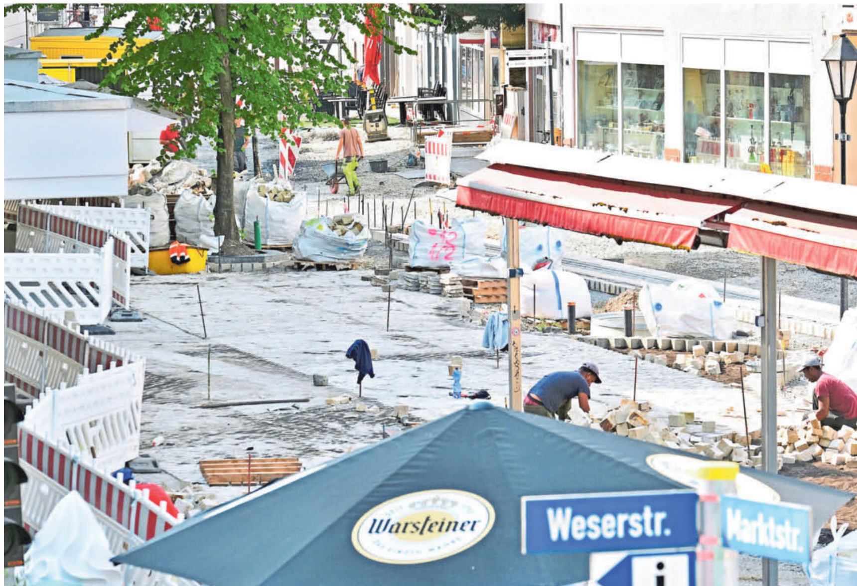
In der Höxteraner Innenstadt gibt es weiterhin große Baustellen – wie hier in der Stummrige Straße. Die Firmen sind in der Außengastronomie stark eingeschränkt.
