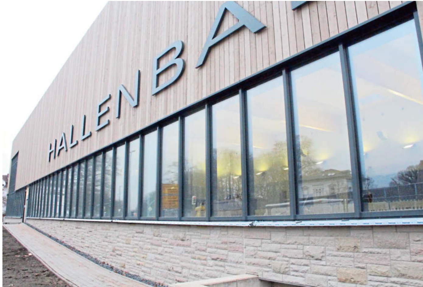
Das neue Höxteraner Hallenbad steht kurz vor der Fertigstellung.
