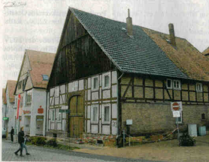
Gibt's so nicht mehr: Der Giebel des Ackerbürgerhauses in Borgentreichs Stadtmitte hatte sich nach außen geneigt. Anfang Dezember wurde das Ackerbürgerhaus komplett abgerissen. ARCHIV-FOTO: S. WAMERS
