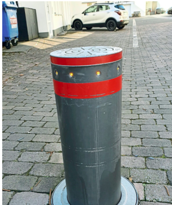
Der Rat Höxter kann sich als Verschärfung der Sicherheitsmaßnahmen solche versenkbaren Poller (hier am Standesamt Höxter) an den Straßenzugängen gut vorstellen. Sie werden nur zweitweise bei Großveranstaltungen hochgefahren und sorgen für ein Mindestmaß an Schutz vor Anschlag-Fahrzeugen. Die Poller werden ein Thema. Foto: Michael Robrecht
